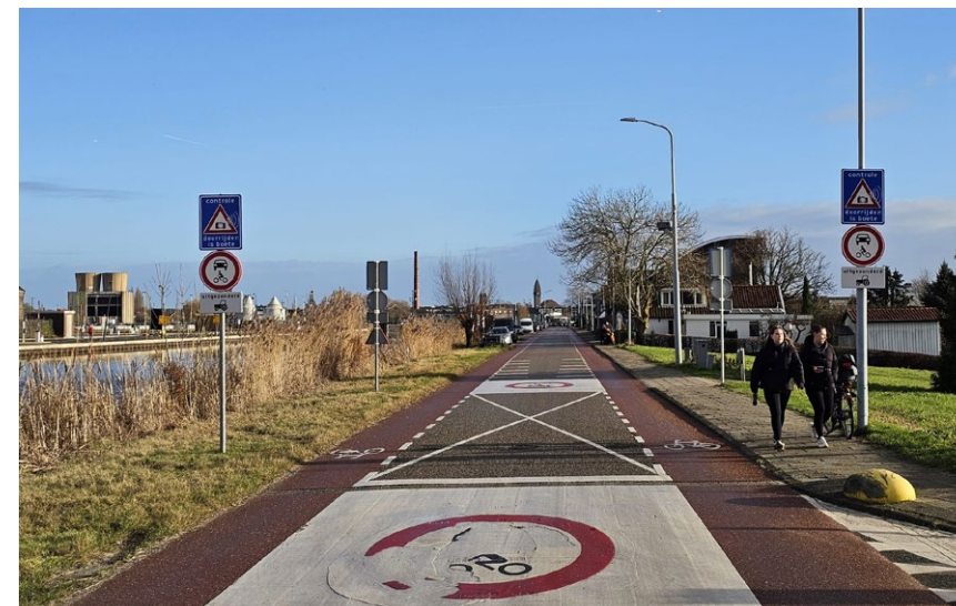
Voorbeeld zachte knip met toegangscontrole door camera's
