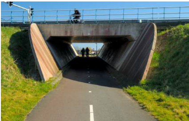
Fietstunnel N244 - N247 Edam
