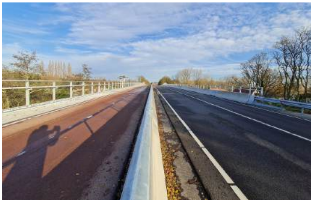
Oude Haagsebrug, waar een doorfietsroute en vrije busbaan is gerealiseerd, sectie 10
